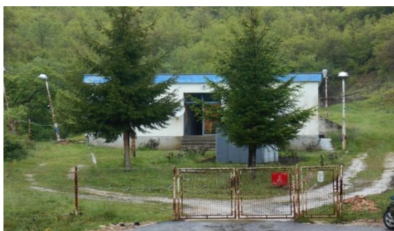
Fotografija 2. Pumpna stanica na izvoru Krupića Izvor: Zvonimir Faletar
